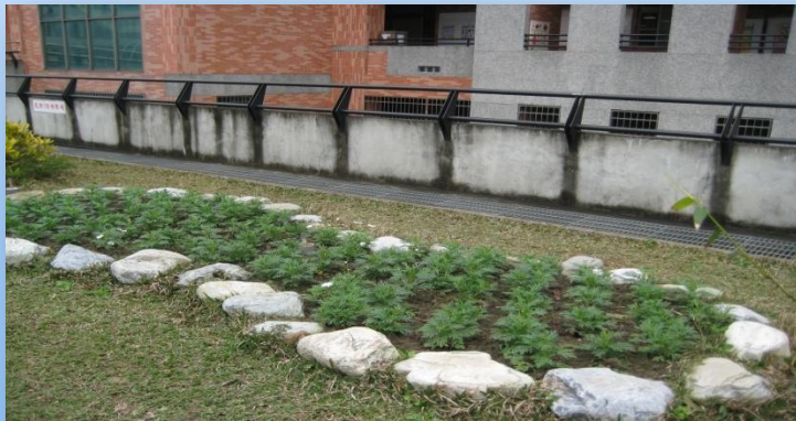
老舊污損矮牆 與校園景觀無法融合
